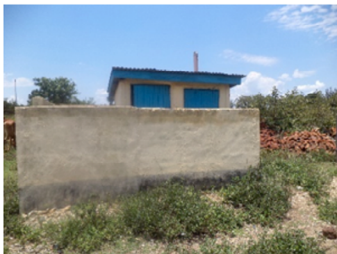
Kababu VIP toilet
